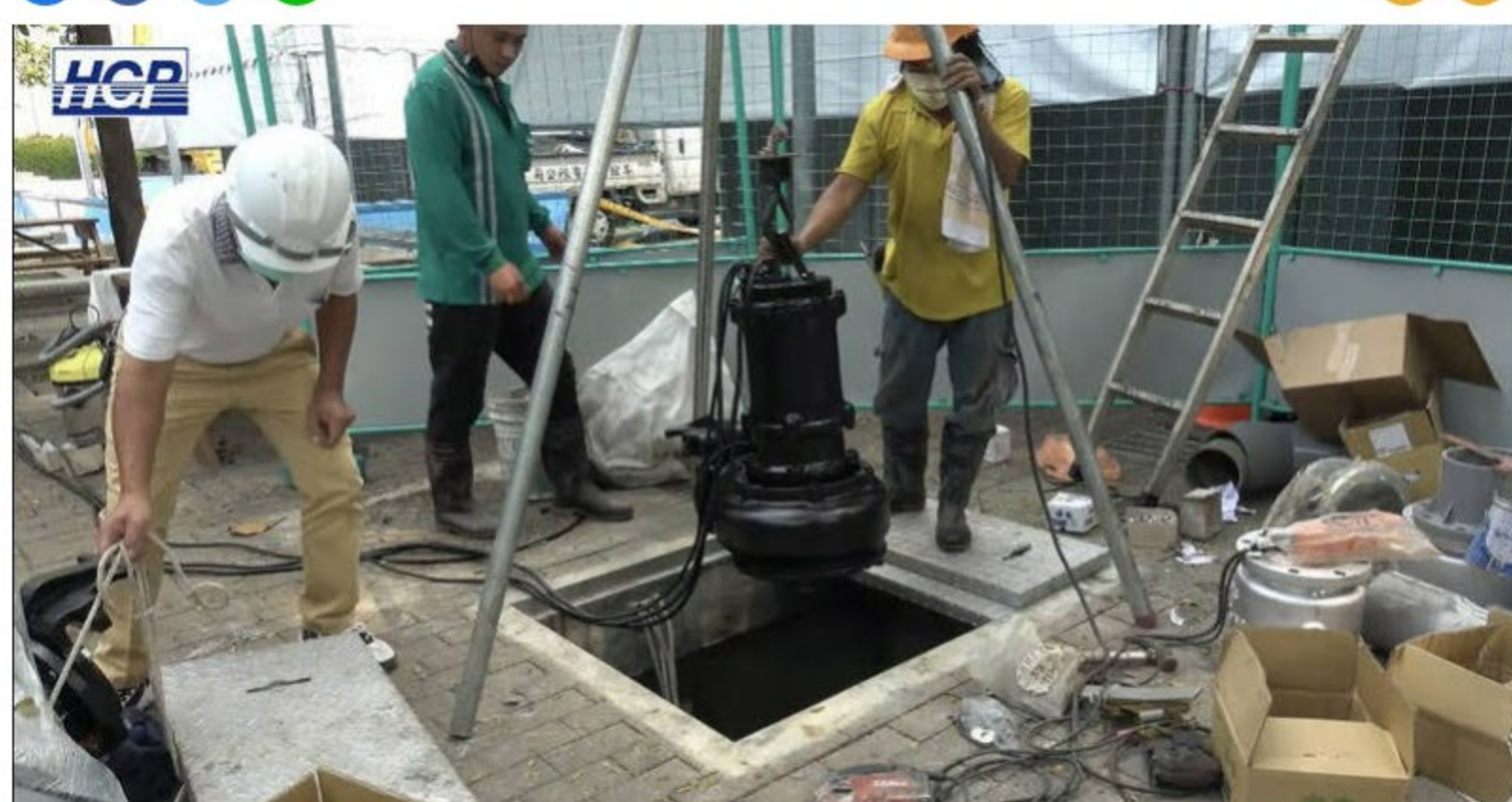
泵浦裝設情形。(河見電機工業提供)
