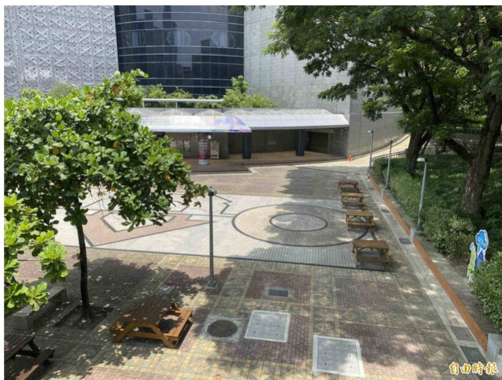
沉水式泵浦裝設，大幅改善淹水狀況。(記者黃旭磊攝)
